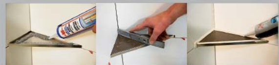
Fliese oder Glas mit Neutralsilikon bzw. Spezialkleber anbringen
